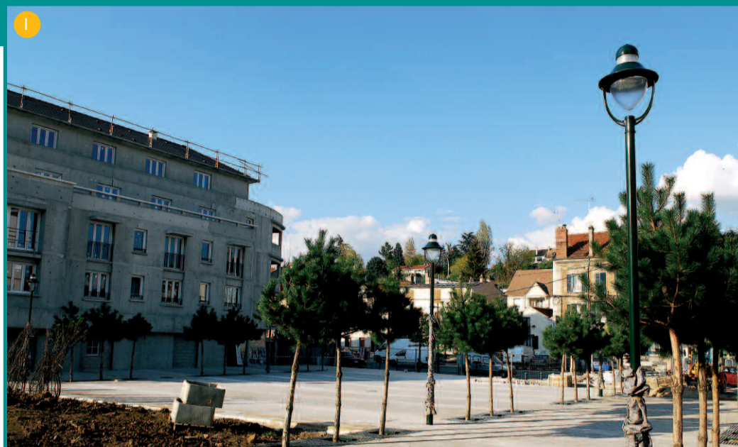
La Ville de Corbeil-Essonnes aménage la nouvelle place Alzira.
