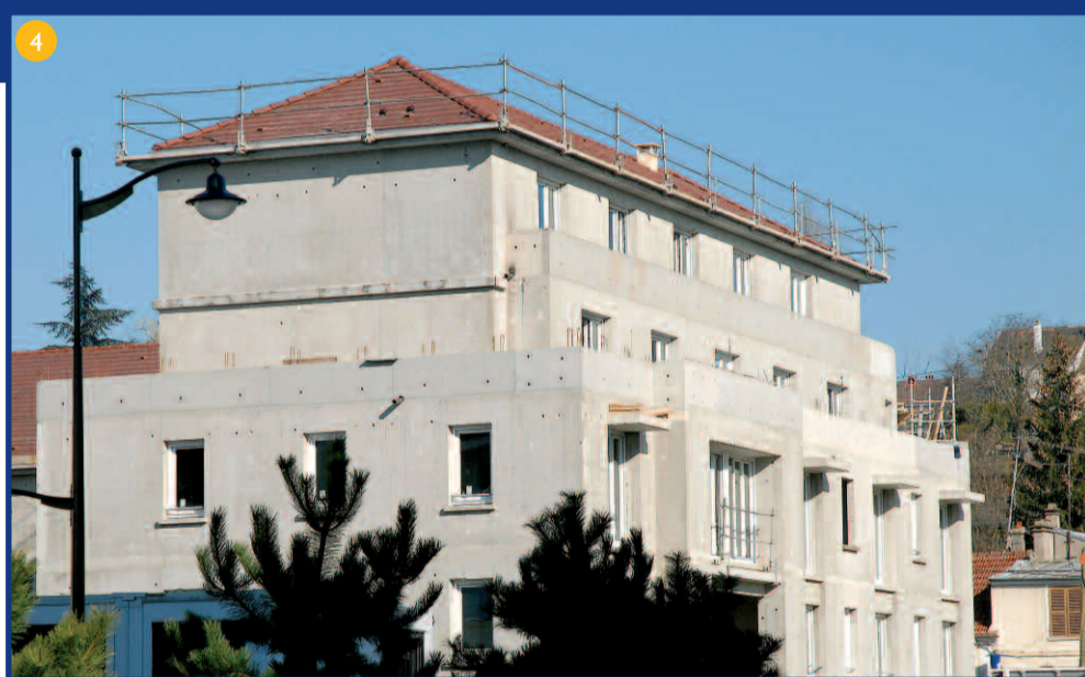
Immobilière 3F termine la construction de 24 logements sociaux situés place Alzira. La PMI sera installée en rez-de-chaussée. La livraison est prévue pour septembre 2008.
